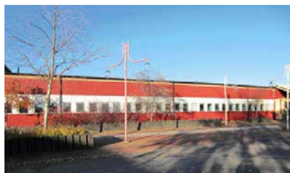
Fig 2. D-huset vid LTU i halva dess längd. Foto: Agne Rustan 18 okt 2018.
