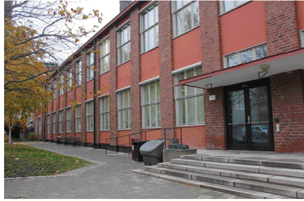
Fig 5. Lokaler för Institutionen för Gruvbrytning med Gruvmätning vid Drottning Kristinas väg 6 efter flyttningen från KTH:s västra flygel, Bergsve-tenskap. Foto: Elisabeth Torsner, nov 2018
