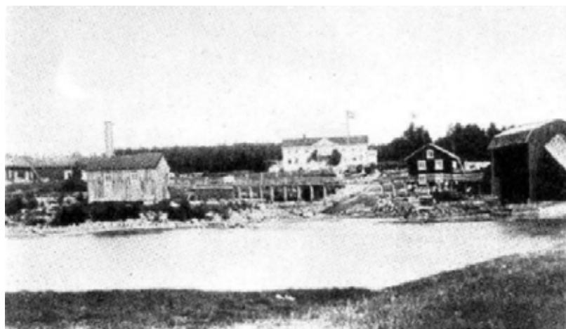
Strömsholms herrgård, Bureå kvarn och Bureå linbladiga vattensåg,
