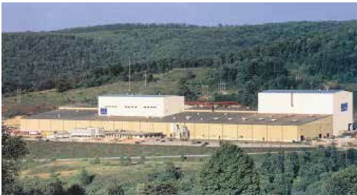
Stoney Creek anläggning i västra Pennsylvania, October 2001
