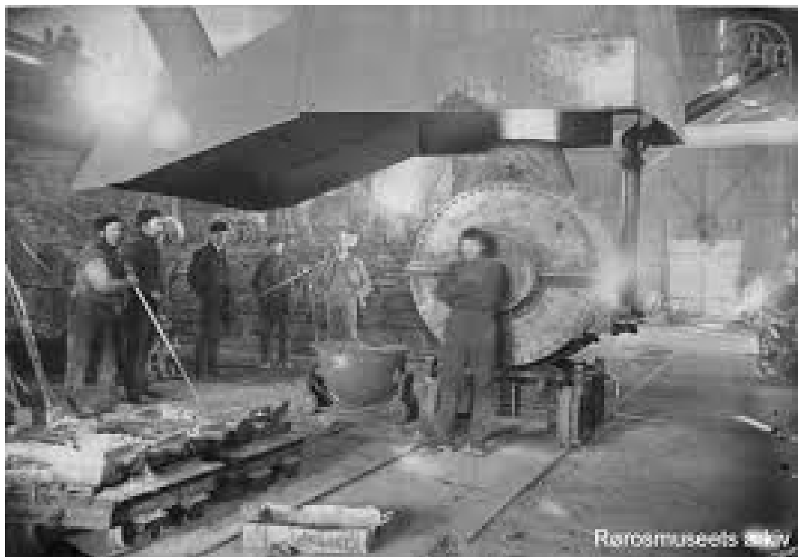
Fig 12. Bessemerkonverter vid Rönros
